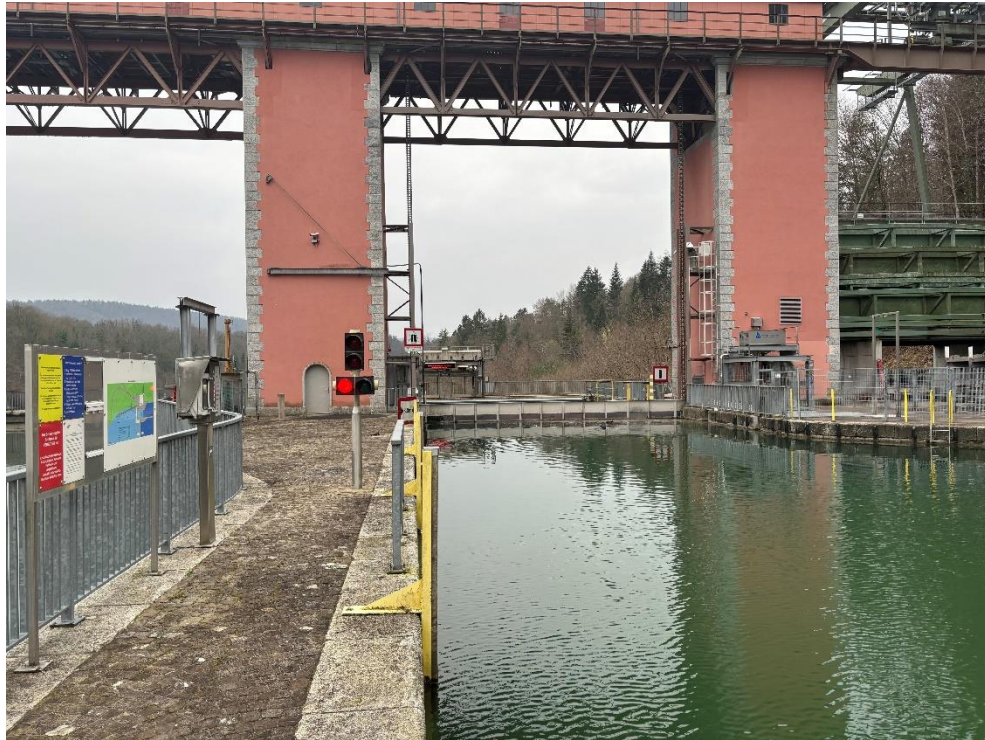
Einfahrt Schleuse Oberwasser
