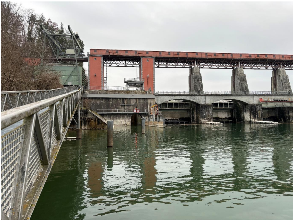
Einfahrt Schleuse Unterwasser
