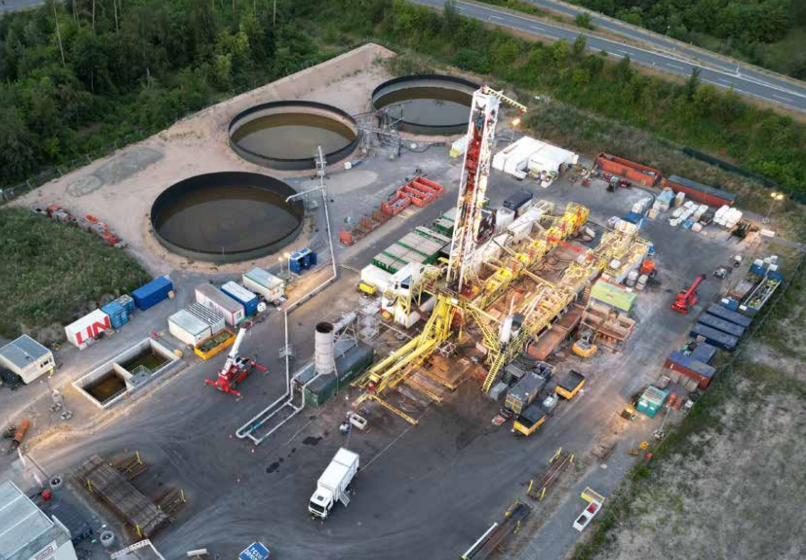
Geothermiebohranlage der Deutschen Erdwärme in Graben-Neudorf.
