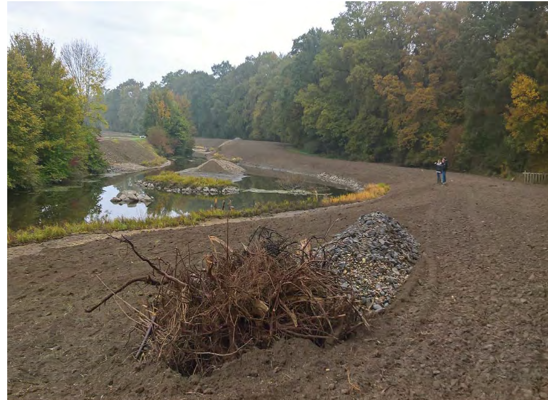
Uferstrukturierung m. Kies&Totholz
