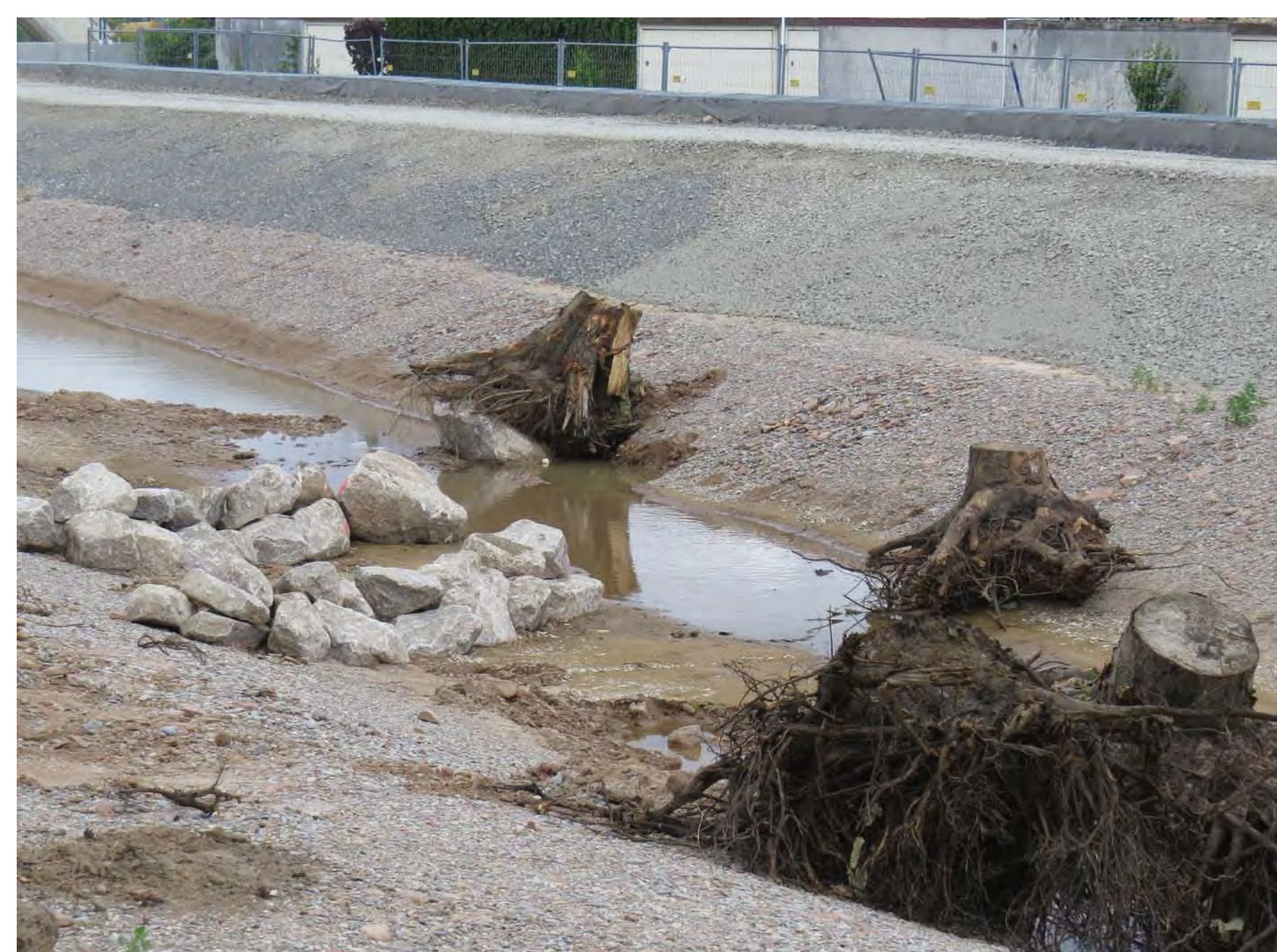
Einbau von Störsteinen und Totholz
